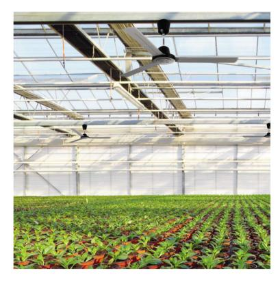
A gama NORDIK Heavy duty é constituída por ventoinhas de teto reversíveis, projetadas especificamente para utilização contínua, mesmo em velocidade máxima e em condições ambientais de limite.
