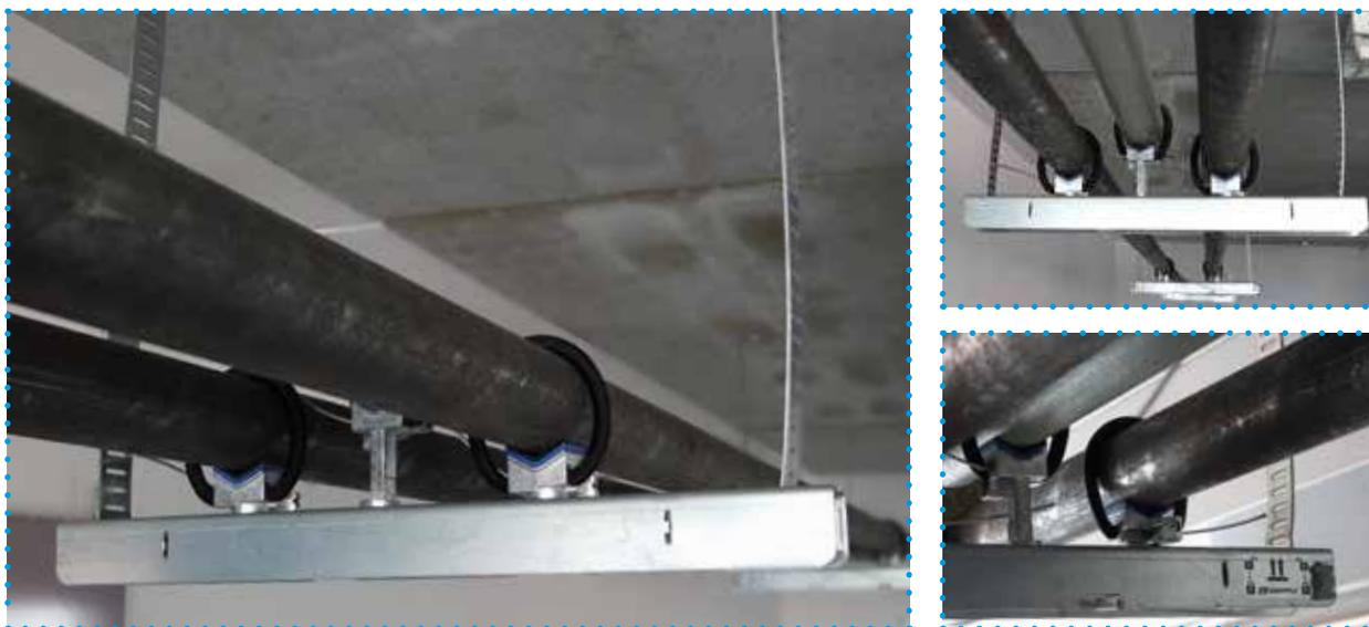
Perfis com comprimentos disponíveis até 1500 mm e Suportes verticais em 285, 535, 785 e 1035 mm
