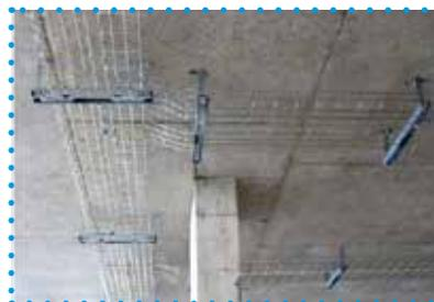
Perfis com comprimentos disponíveis até 1500 mm e Suportes verticais em 285, 535, 785 e 1035 mm
